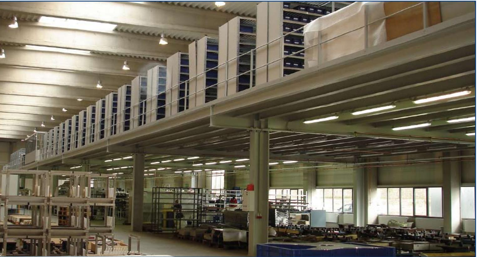
**Stahlbaubühnen ermöglichen beste Raumausnutzung durch Ausnutzung der Hallenhöhe für mehrere Lager-, Fertigungs- oder Büroflächen.**
